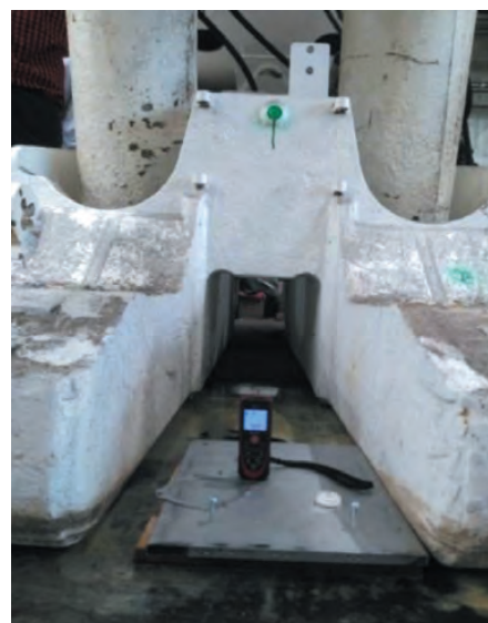
Rys. 5. Ręczny pomiar wysokości pracy obudowy zmechanizowanej
