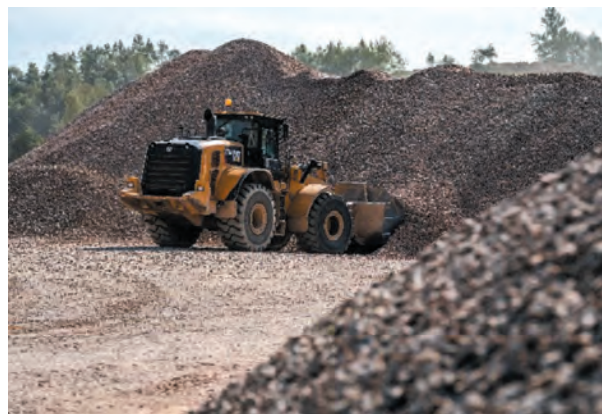
Rys. 17. Ładowarka podczas prac porządkowych
