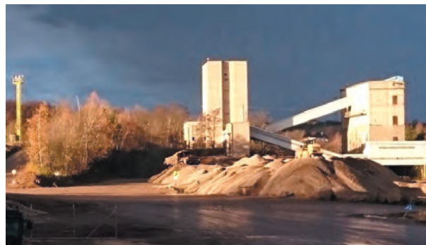
Rys. 15. Zakład przerobczy Kopalni Porfiru „Zalas”
