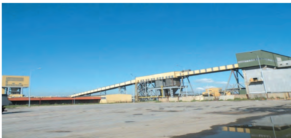
Rys. 19. Przenośniki do transportu rudy miedzi i soli kamiennej
