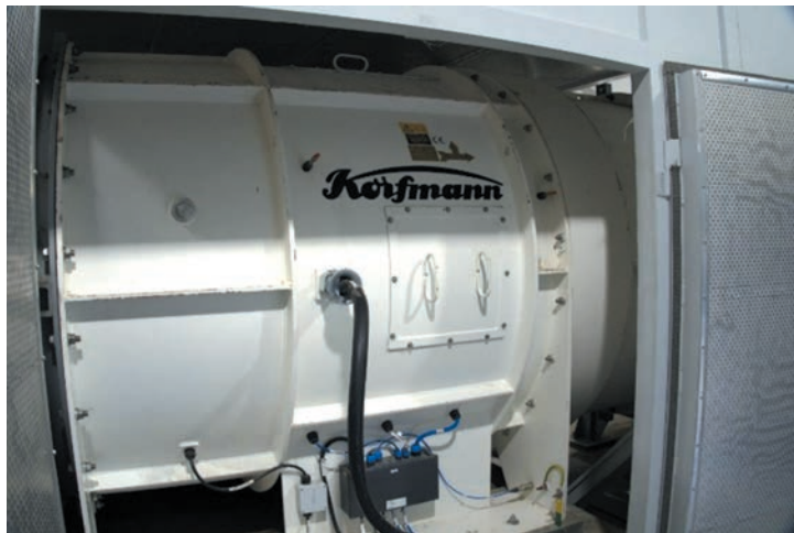
Rys. 4. Wentylator typu dAL16-1100 produkcji firmy Korfmann
