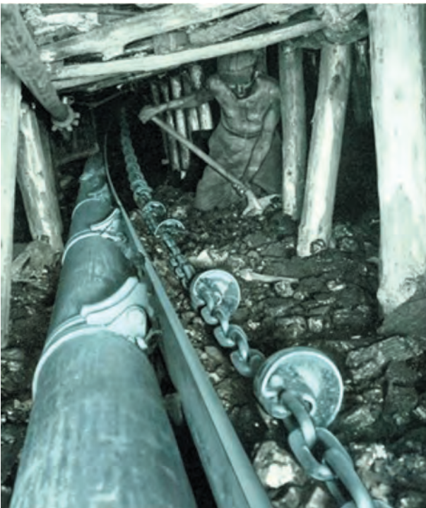
Rys. 2. Hamujący przenośnik tarczowy [4, 5, 8]
