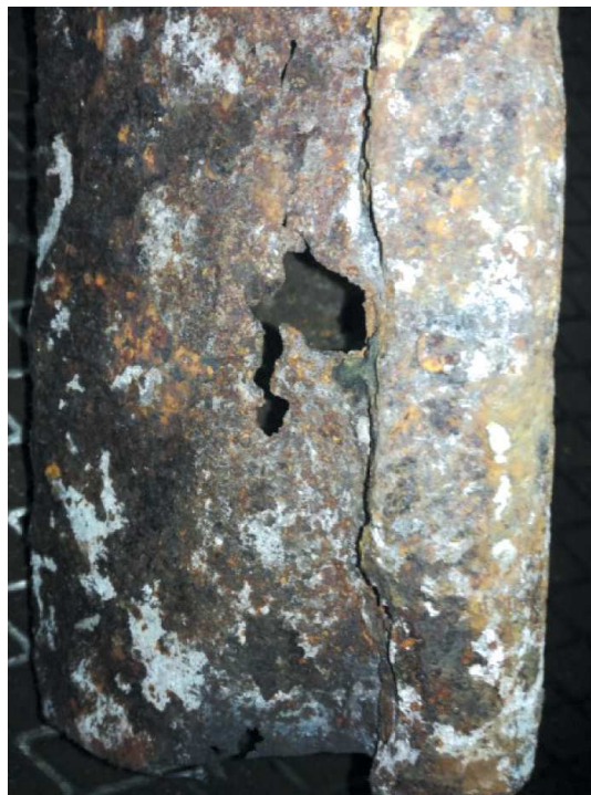
Rys. 2. Perforacja kształtownika w rejonie jego kołnierza
