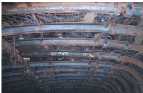
Rys. 47. Rozcinka zabezpieczona obudową ŁPrw
