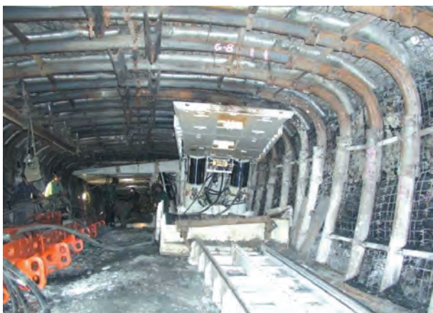
Rys. 44. Dworzec zrealizowany w obudowie ŁPrP, wykonanie Ł
