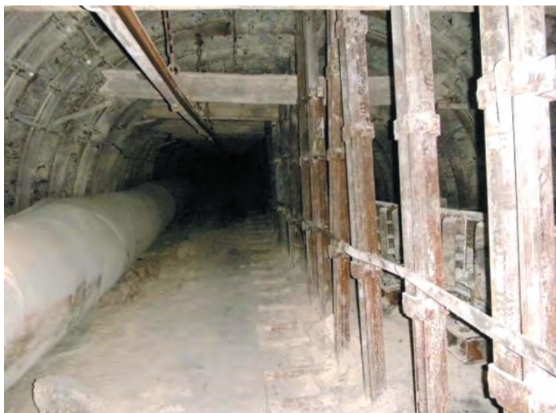
Rys. 16. Rozcinka zabezpieczona obudową ŁPKO
