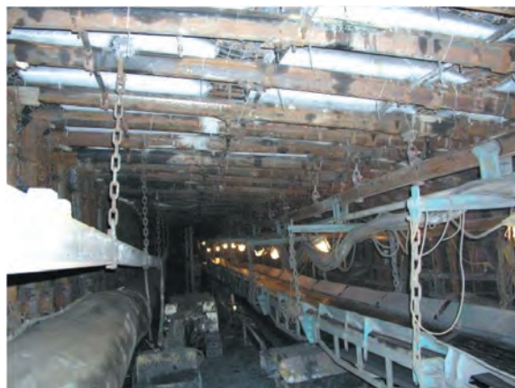
Rys. 24. Rozcinka ścianowa zabezpieczona obudową ŁPro/A
