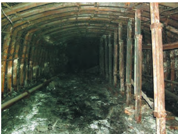
Rys. 33. Rozcinka ścianowa zabezpieczona odrzwiami ŁPrP czteroelementowymi
