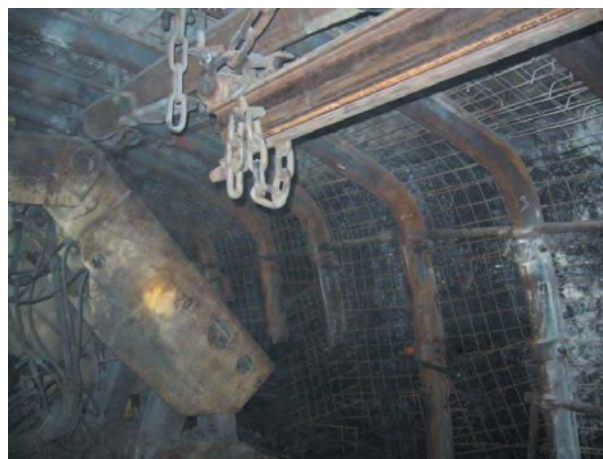
Rys. 34. Zbrojenie ściany, rozcinka zabezpieczona odrzwiami ŁPrP czteroelementowymi
