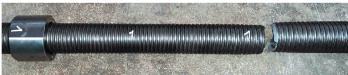
Rys. 10. Zerwana żerdź kotwi T111 po próbie rozciągania
