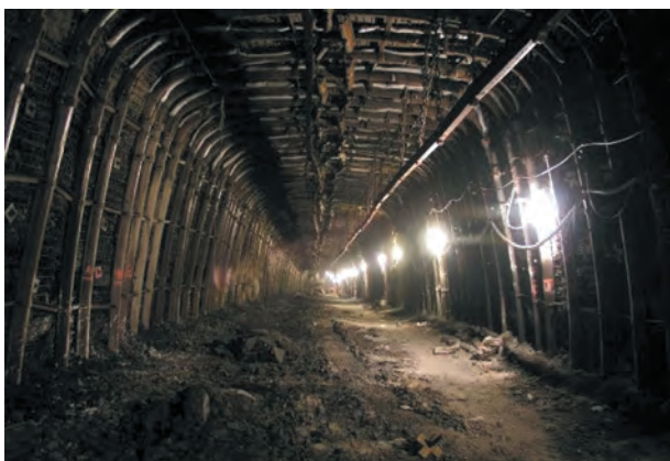
Rys. 39. Rozcinka ścianowa zabezpieczona obudową ŁPrP, wykonanie Ł
