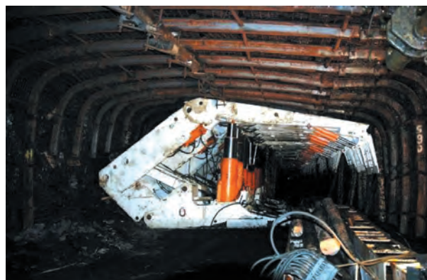
Rys. 48. Zbrojenie ściany, przecinka zabezpieczona obudową ŁPrw
