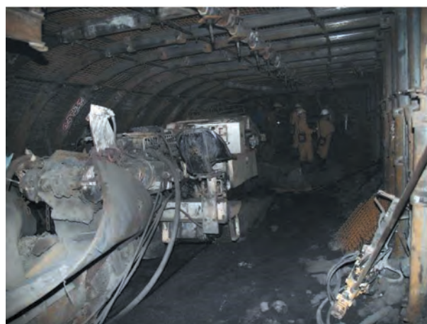
Rys. 20. Kanał likwidacyjny ściany zabezpieczony obudową ŁPro/B
