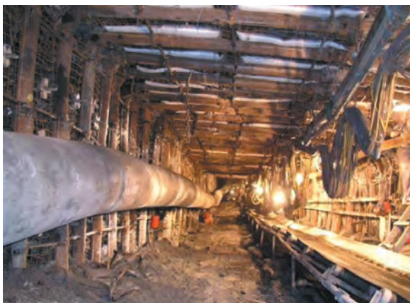
Rys. 23. Rozcinka ścianowa zabezpieczona obudową ŁPro/A
