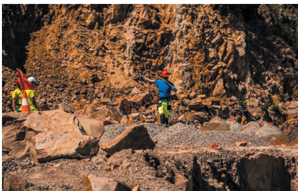
Rys. 8. Prace strzałowe wykonywane przez SSE
