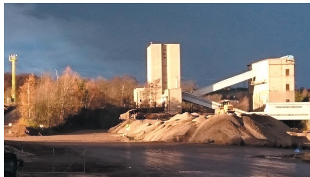
Rys. 15. Zakład przeróbczy Kopalni Porfiru „Zalas”
