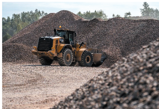
Rys. 17. Ładowarka podczas prac porządkowych
