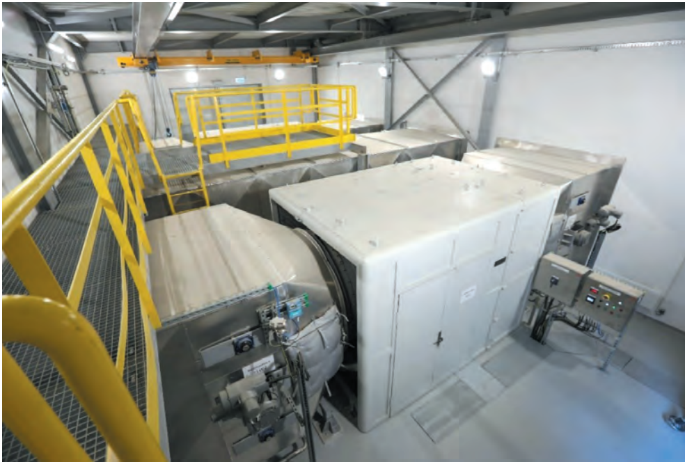
Rys. 5. Szyb „Wilson” po modernizacji (fot. R. Stachurski)
