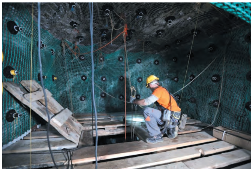
Rys. 6. Prace w szybiku „Geramb” (fot. R. Stachurski)
