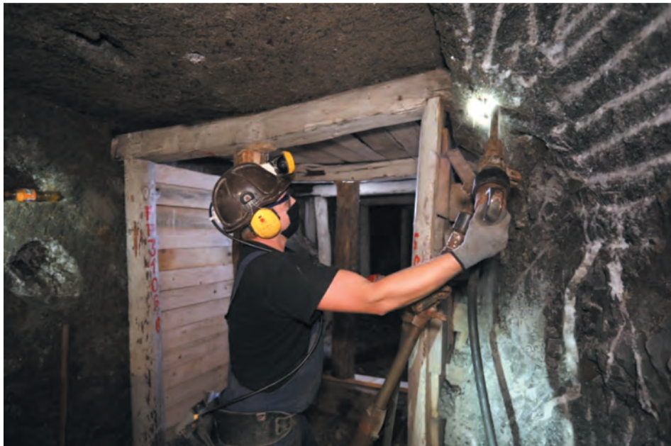
Rys. 8. Przebudowa podłużni „Lillienbach” (fot. R. Stachurski)
