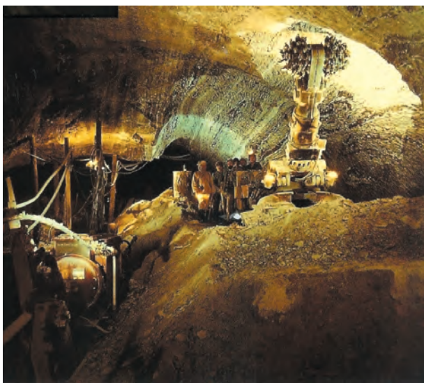
Rys. 1. Wykorzystanie kombajnu AM-50 przy przebudowie wyrobisk Komory „Ważyn” (fot. zbiory Kopalni Soli „Bochnia”)
